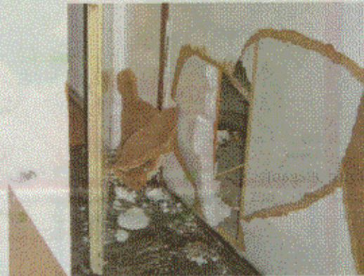
... und von innen, der Gesamtschaden beträgt rund 40
