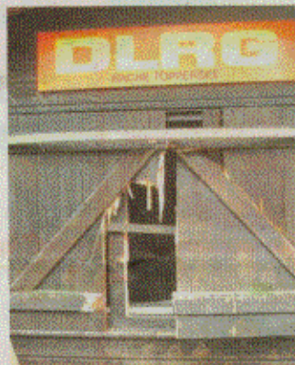
Die zerstörte Front von außen...
